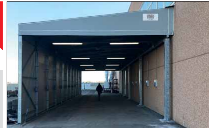
Tunnel monopendente zoppo adibito ad area ricarica carrelli
